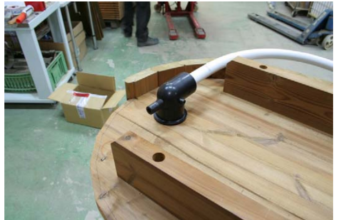
La bonde doit être tournée sur le côté car vous ne pourrez pas accéder au tuyau d'évacuation. Le tuyau de vidange doit être placé entre le pied de la cuve et la base des lattes.
