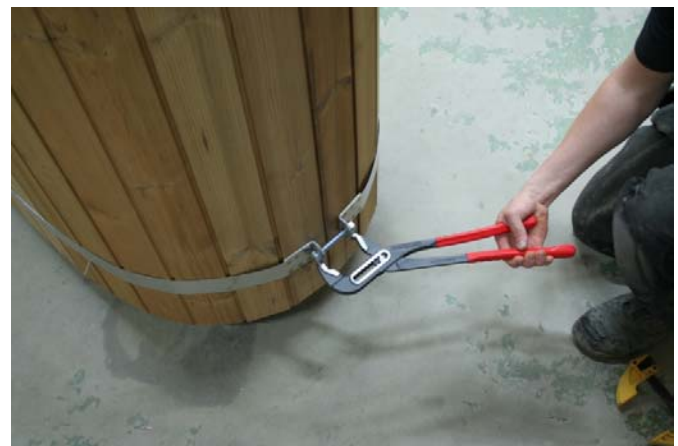
Si le boulon de serrage est trop court, vous pouvez utiliser une pince multiprise pour serrer les arceaux. Vous trouverez également un boulon plus long.
