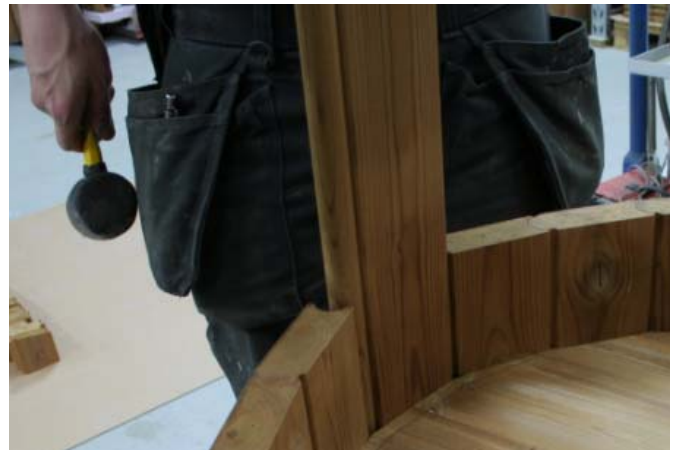
Selon la photo, placer la dernière latte avec l'aide un maillet en caoutchouc. Taper au niveau de la gorge jusqu'à ce que les dernières lattes soient placées sur le bord de la ligne marquée.
